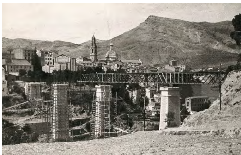
Imagen superior: la tercera solución del viaducto de Canalejas, del ingeniero Próspero Lafarga Navarro. Fuente: LAFARGA NAVARRO, Próspero. (1902). «Viaducto de Alcoy sobre el río Molinar», en Revista de Obras Públicas . Tomo I (número especial 1936-1939 dedicado a la guerra), pág. 112. Debajo, avance y “lanzamiento” de la viga-celosía del viaducto de Canalejas sobre las pilastras, 1905. Foto: José Crespo Colomer.
